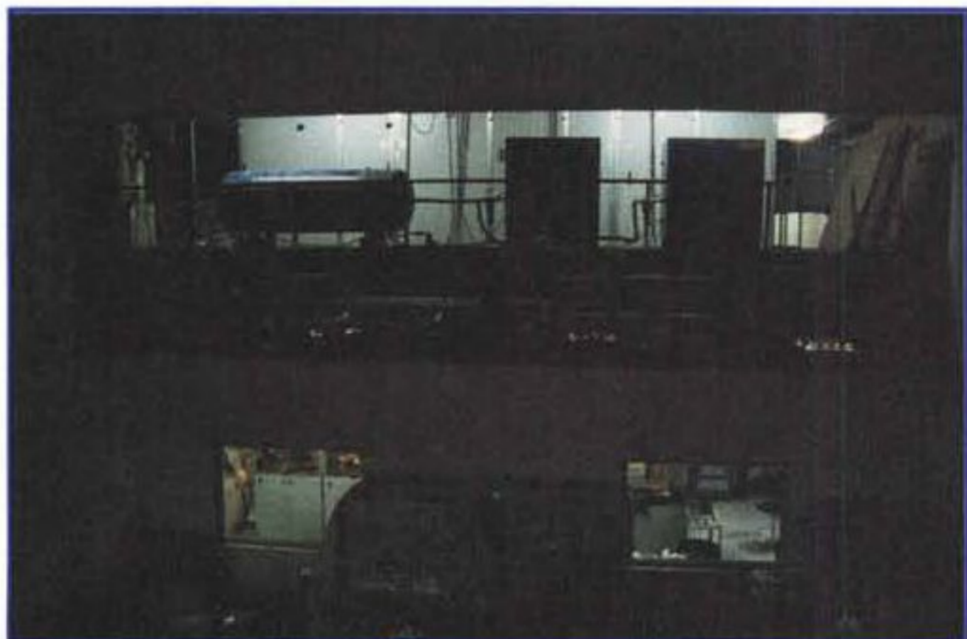
Questi sono parte degli impianti della Nacar Media. Nella parte inferiore della foto notiamo uno scorcio della stanza a clima controllato nella quale si costruiscono fisicamente i CD-R, nella parte superiore invece è visibile l'imponente impianto di condizionamento e climatizzazione, capace di mantenere l'ambiente esente da polvere con una purezza di classe 100.000.
